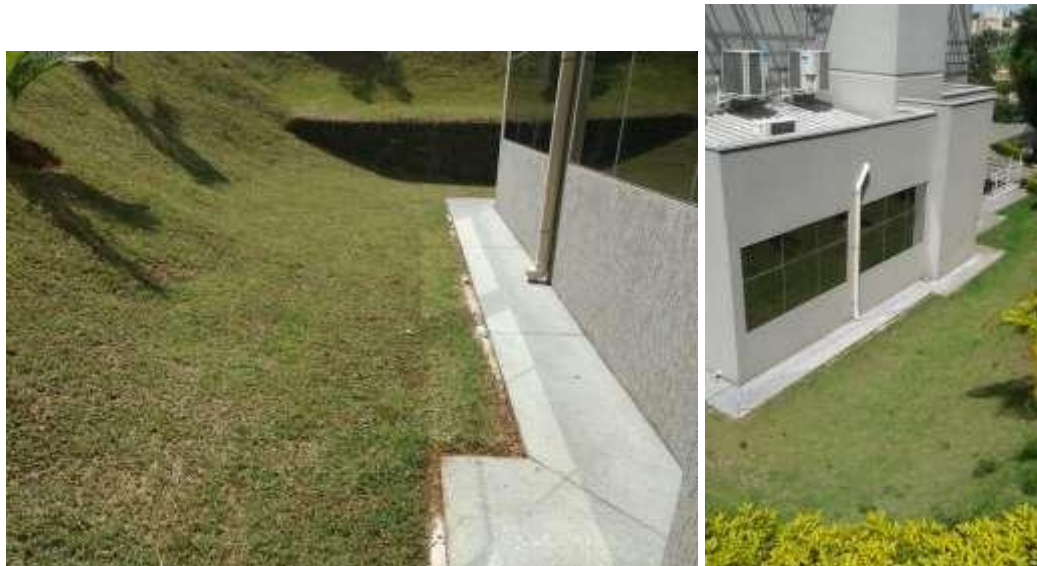
Parede B – Lado Interno e externo
